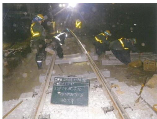
コンクリートまくら木化工事
