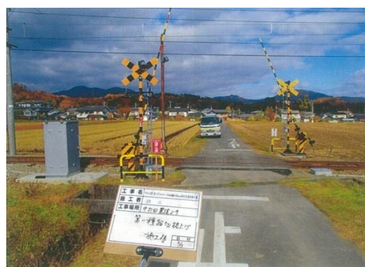
中丸田農道2号踏切道の格上げ
