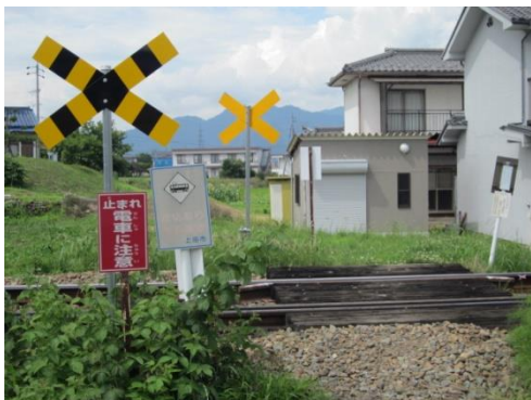
第4種踏切道・警標設置
