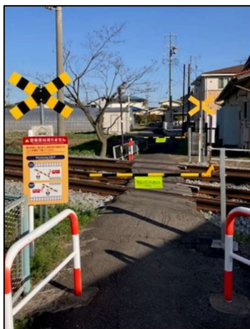
城下構内踏切道
