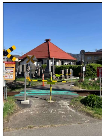
池南 1 号踏切道
