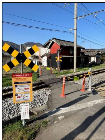
石田 2 号踏切道
