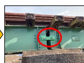
橋脚補強（落橋防止 桁の連結）
