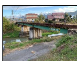
橋脚補強（落橋防止 桁の連結）
