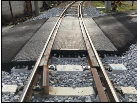
硬頭レール化、軌道道床硬質構造化
