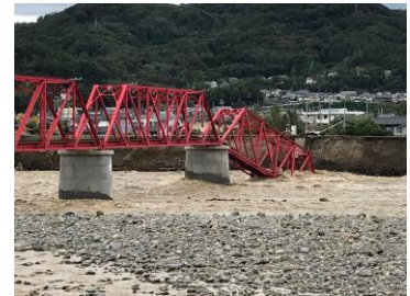
▲崩落した別所線鉄橋
